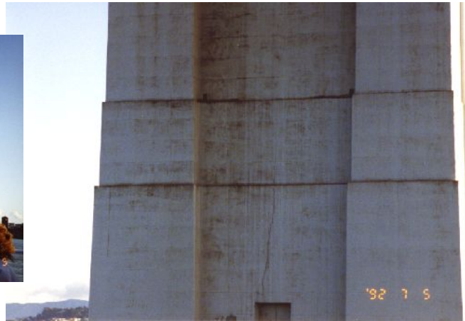
ゴールデンゲートブリッジの橋脚土台の割れ（サンフランシスコ）
